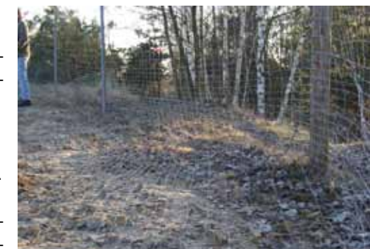
Unterwühlenschutz mit Knotengeflecht am Boden
